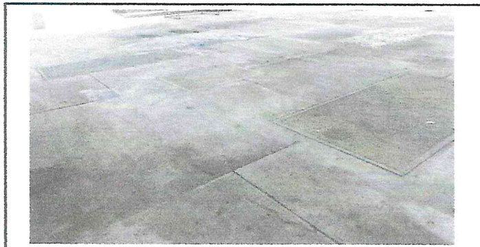
Foto 3: Reparación de planchas de concreto de patio
