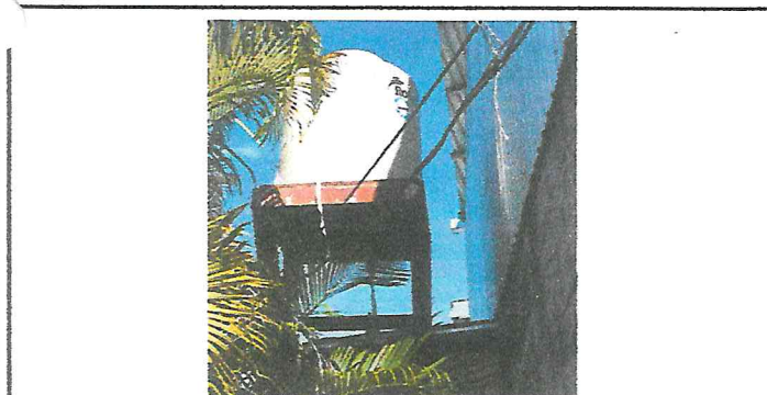
Foto 5: Sustitución de depósito de agua 1,000 lt.
