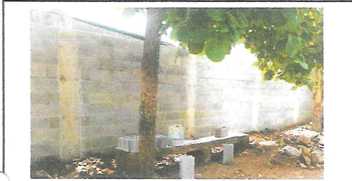
Foto1: Reparación del muro perimetral de block
