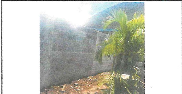
Foto 2: Reparación de muro perimetral de block
