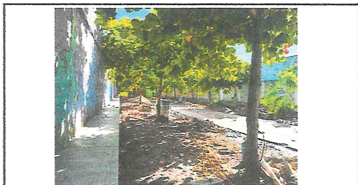
Foto 6: Reparación de banquetas de concreto
