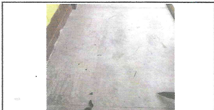
Foto 4: Reparación de planchas de concreto de patio
